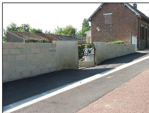
**Remplacement de la haie du cimetière par un mur. Ces travaux sont réalisés par nos agents. Le mur sera fini avant l'hiver et sera habillé de briquettes rouges.**
